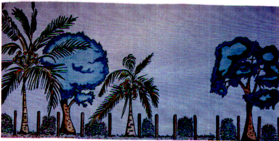
Terrain défriché piqueté et andainé (Végétation abattue rangée en andains)
