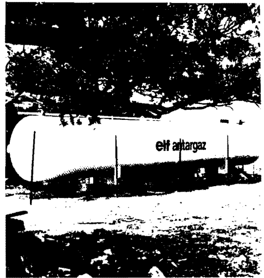
Cuve de propane pour l'alimentation de la chaudière.
