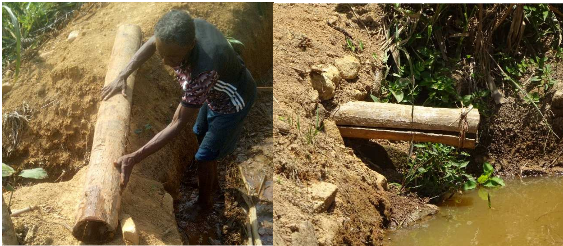
Figure 16: Photos d'un système de vidange en tronc de ravinala chez un pisciculteur
