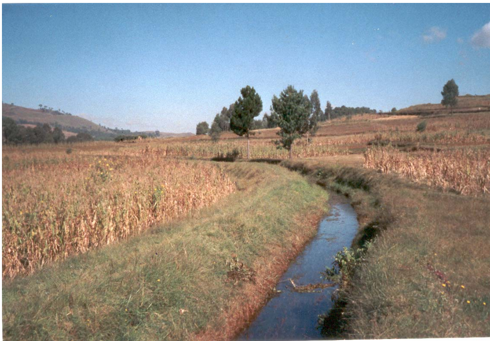
Photo 4 : Canal secondaire d'irrigation
