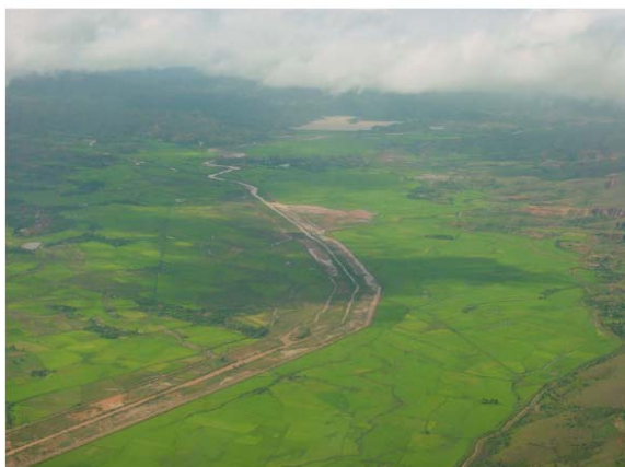
Photo aérienne du barrage et de la VM
