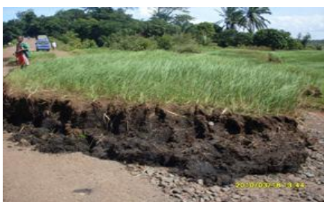
Cliché 3 : Rizière emportée au milieu de la route par les courants d'une rivière (Source : SDmad Farafangana)
