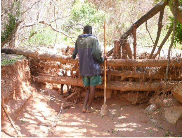
Photo 14 : Fascine, (Ambodirotra - Terroir Ambohitranjakana, 2011)
