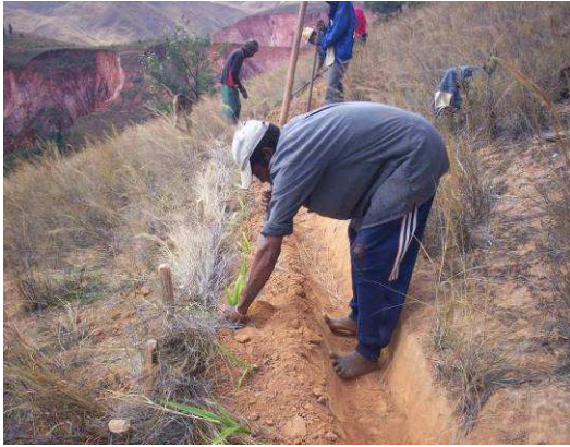
Photo 12 : Cordons de paille et canal d'infiltration, (Ambodirotra - Terroir d'Ambohitranjakana, 2010)
