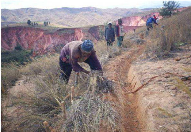
Photo 15 : Canal d'infiltration avec cordon de pailles, (Ambodirotra - Terroir Ambohitranjakana, 2010)
