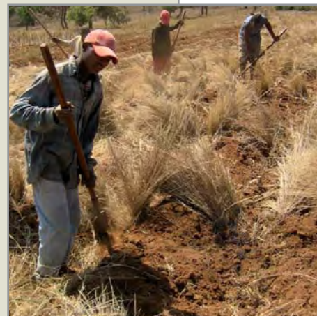
Recouvrement des tranchées et confection des cheminées pour l'allumage Photo : N. Moussa
